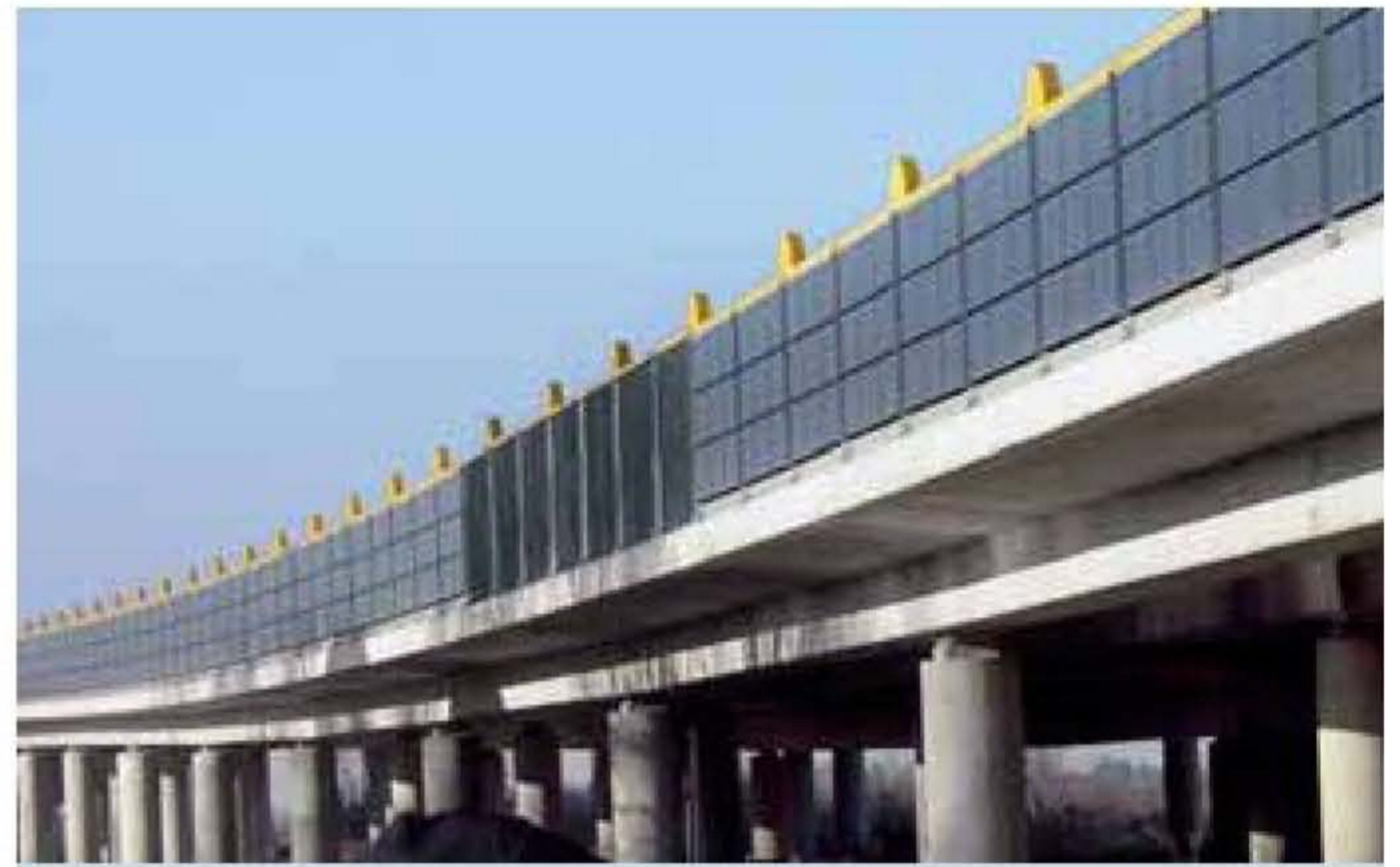
AB Emden · Viena sāna pārklājums ar Saules bateriju elementiem
