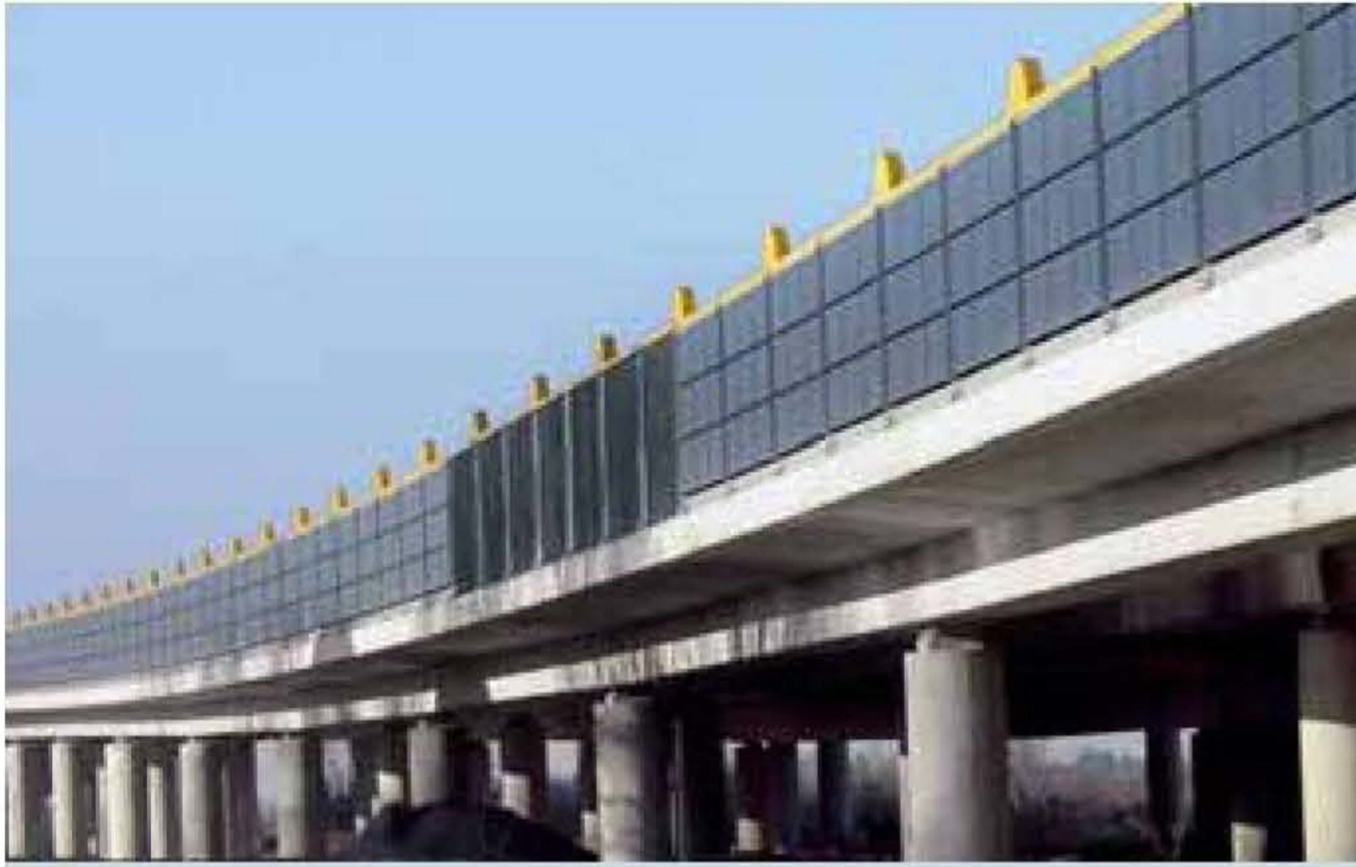
AB Emden · Vienpusējs pārsegums ar Saules bateriju elementiem
